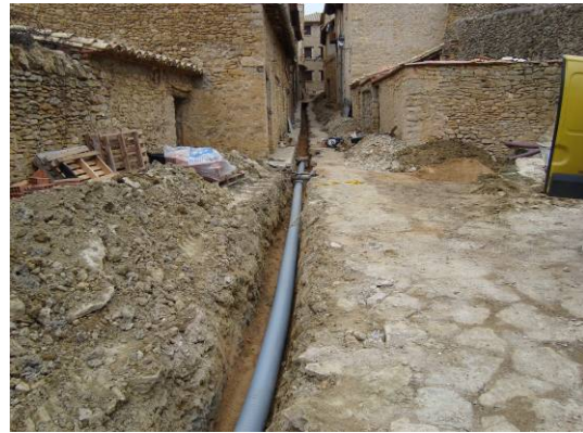
Fotografías 9 y 10. Instalación tubería. Red de calor Todoilella.
