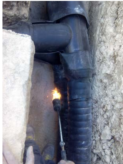
Fotografía 16. Instalación manguitos exteriores en unión acometida.
