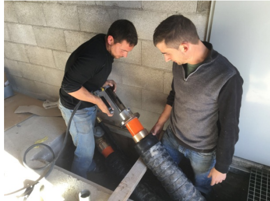
Fotografía 14. Unión mediante casquillo corredizo.
