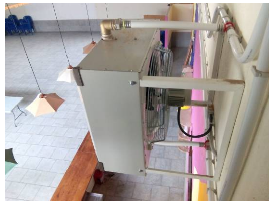
Foto 19 y 20. Ventiloconvectores instalados en el polideportivo de Todoella.
