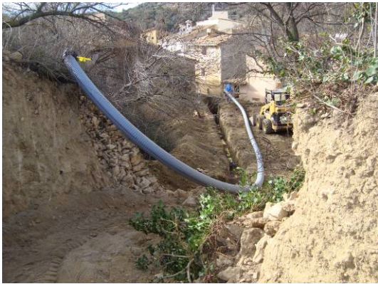
Fotografías 9 y 10. Instalación tubería. Red de calor Todoilella.
