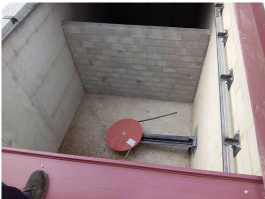
Fotografías 5 y 6. Silo central generación de calor y descarga de astilla directa. Red de calor de Todolella.
