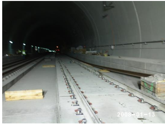
Figura.- Vía en placa desarrollada por AFTRAV
