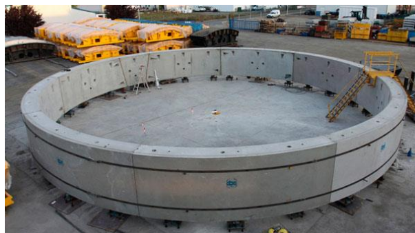
Figura.- Dovelas para Alaskan Way Viaduct en Estado Unidos
