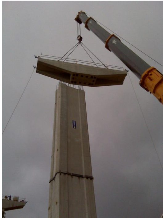
Figura.- Colocación dintel prefabricado sobre pilas prefabricadas
