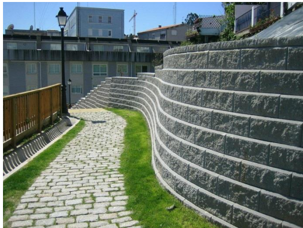
Figura.- Ejemplo de muro de contención segmentado en el que puede apreciarse la pendiente. La forma de las piezas y su aparejo genera un plano de fachada con una determinada pendiente
