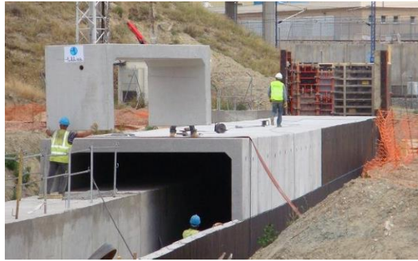
Figura.- Semimarco colocado de manera individual
