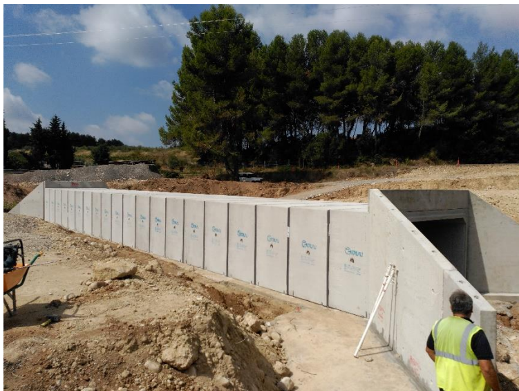
Figura.- Obra de drenaje transversal
