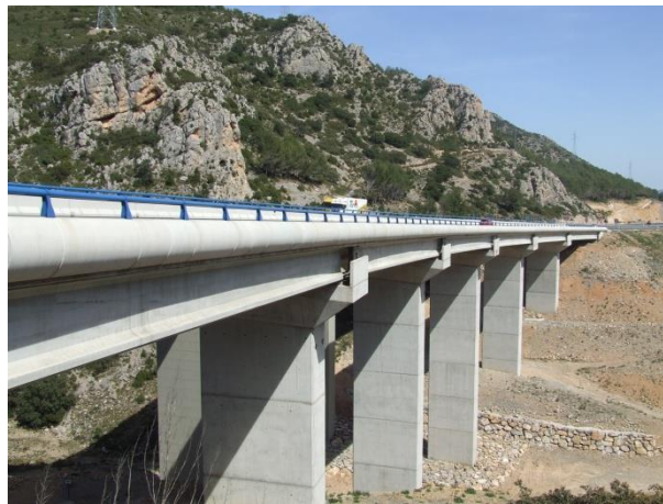
Figura.- Pretil con la cara exterior redondeada y con pasamanos metálico
