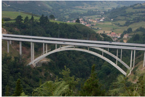
Figura.- Viaducto de Cieza (Santander). Arco construido con dovelas prefabricadas: 5,5 m ancho; 2,60 a 1.8 m canto lineal y espesor 0,25 m.
