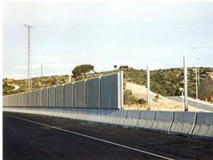
Figura.- Margen de la carretera conformado por barreras y paneles acústicos prefabricados de hormigón
