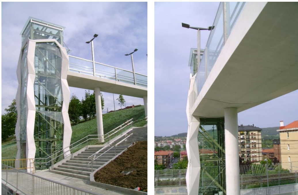
Figura.- Vigas artesa, pilares circulares y paneles arquitectónicos en la ejecución de las pasarelas para ascensores en Algorta (Vizcaya), todos los elementos han sido fabricados con hormigón fotocatalítico de color blanco y absorberán la contaminación del entorno durante toda su vida útil
