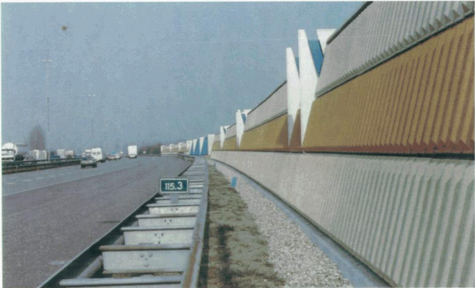
máxima del ruido del orden de 10 dB(A). Si se desea una mayor reducción se puede realizar una cubierta parcial de la calzada. Esta cubierta se ha construido a lo largo de 1.600 metros.
