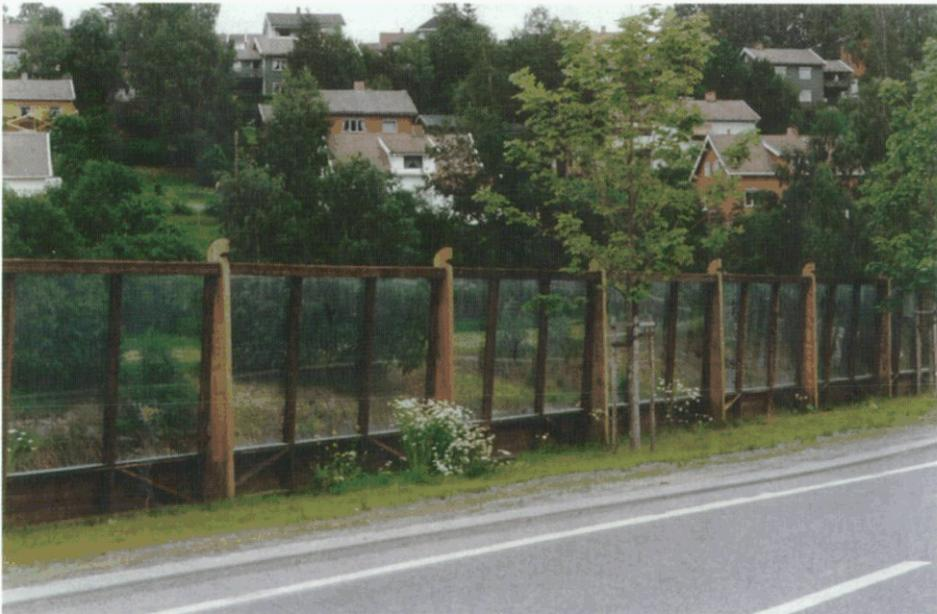
Algunas veces se deja un vacío en la parte inferior de las pantallas anti-ruido de forma que (1) no haya necesidad de instalar un drenaje especial; (2) los pequeños animales puedan circular libremente y (3) que los costes de mantenimiento sean más bajos puesto que no hay contacto entre el suelo y la pantalla. Un estudio acústico sobre estos huecos ha demostrado que una apertura de 20 cm. de ancho disminuye de 1 a 2 dB(A) o más la reducción del ruido por la pantalla.
